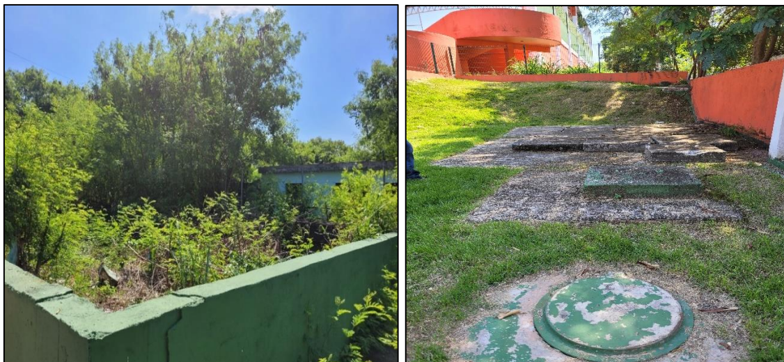
Figura 21 – ETE desativada no Município de Nilópolis.
