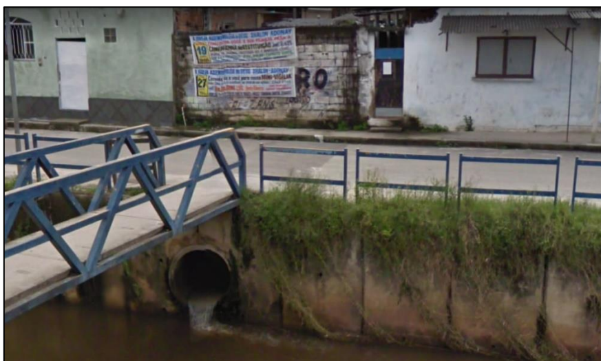
Figura 20 – Disposição de esgotos domésticos diretamente no rio Pavuna na Rua Beira Rio esquina com a Rua Pracinha Wallace Paes Leme.
