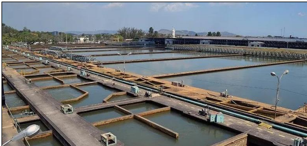
Figura 18 – Vista da Estação de Tratamento de Águas do Guandu em Nova Iguaçu.
