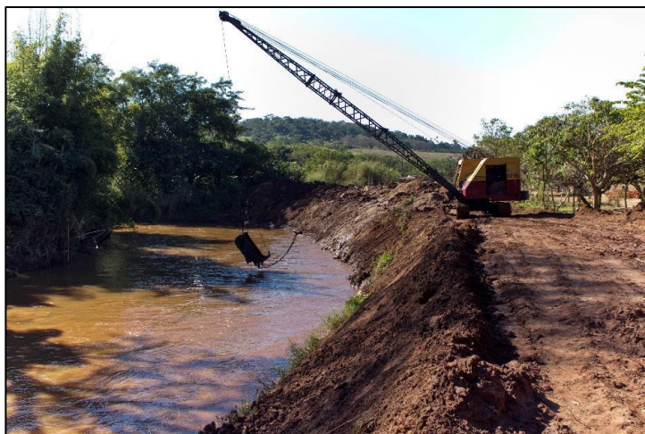
Figura 50 - Exemplo de alargamento e desassoreamento.
