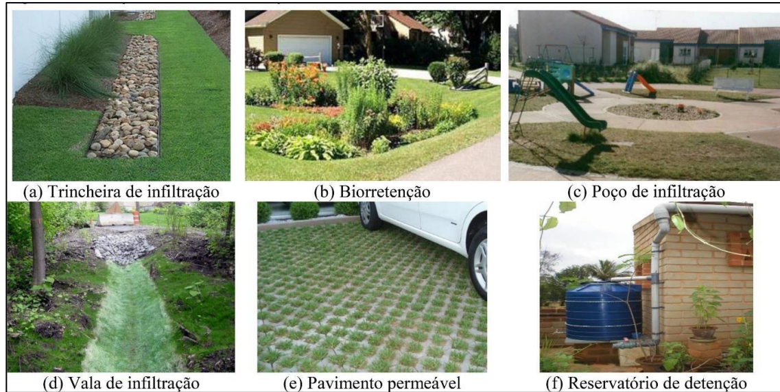
Figura 60 - Exemplos de controles na fonte.
