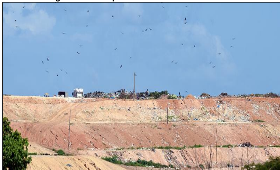
Figura 34 - Exemplo de aterro controlado.
