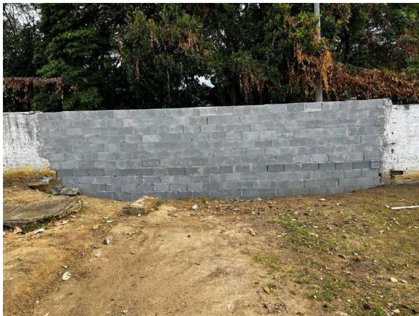
Recuperação do muro do cemitério
