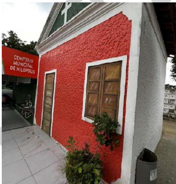
Capela área interna do cemitério Não está em operação
