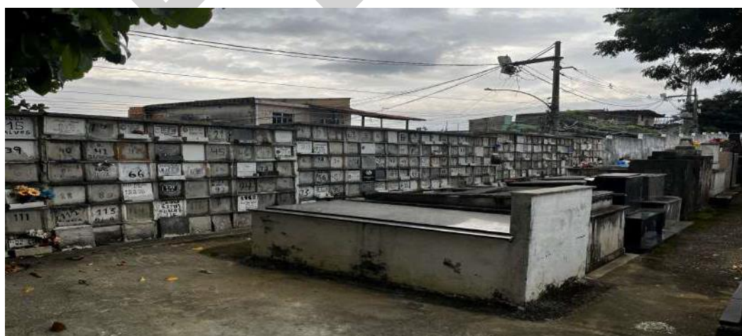
Nichos implantados no muro do cemitério
